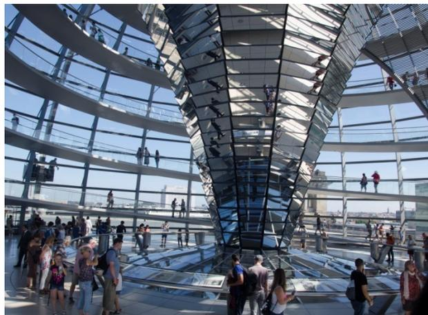
Рис. 2. Система зеркал купола
