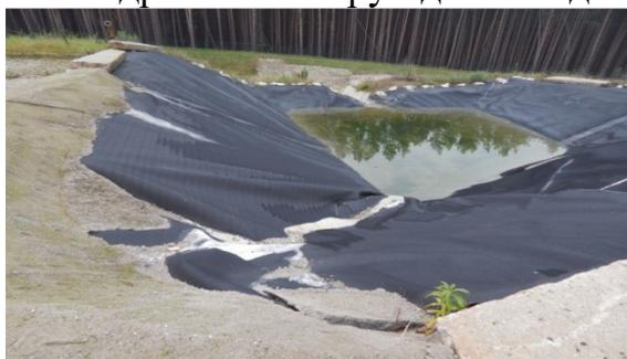
Рис. 2. Укладка изолирующей поверхности
